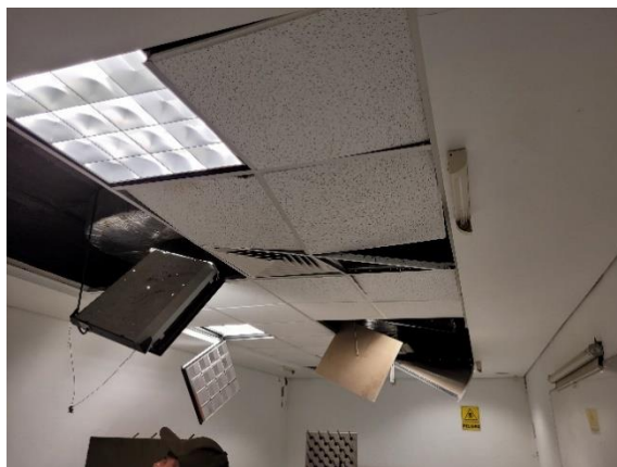
Figura 4.16 Daños en Laboratorio Multidisciplinario: a) muros divisorios con daño por no estar debidamente desligados de los marcos de concreto reforzado, b) caída de plafones por un inadecuado sistema de sujeción (continuación)
