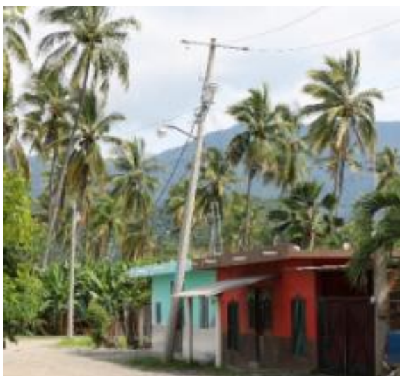
Figura 3.36 Postes de concreto para líneas de transmisión inclinados en El Ticuiz
