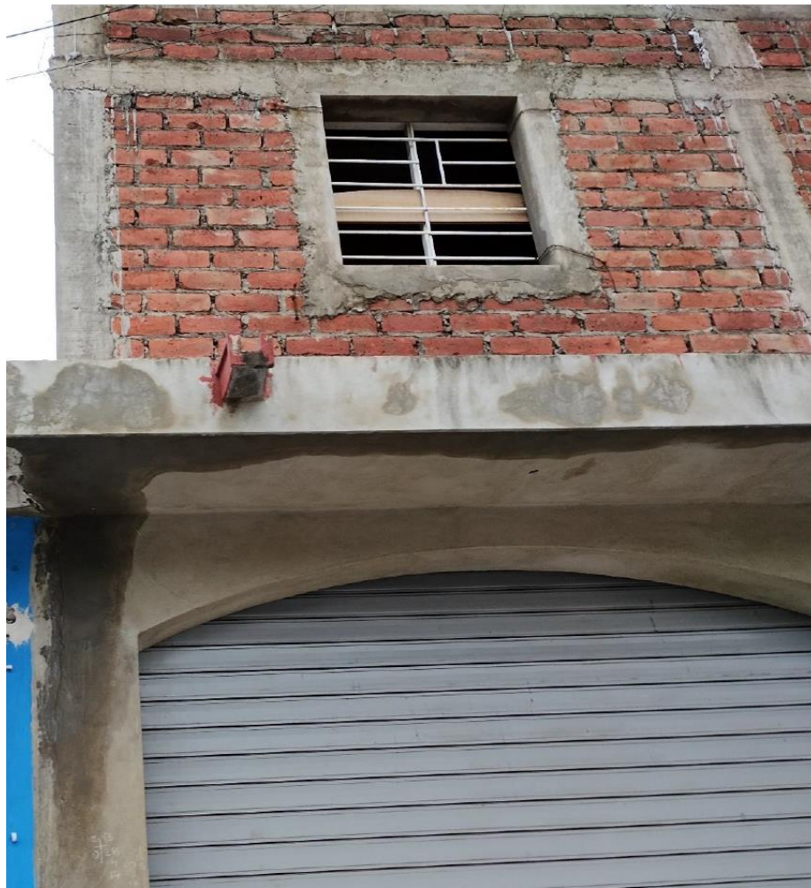
Figura 9.7b Otro caso mostrando la eficacia de los elementos de confinamiento. Fuente: CENAPRED (2022)
