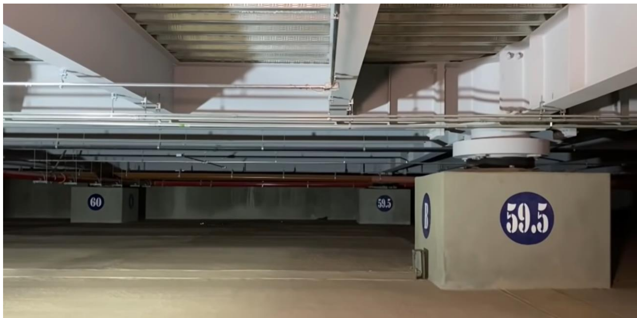
Figura 8.6 Fotografía de aisladores bajo la terminal de pasajeros del AIFA. Fuente: YouTube (2023)
