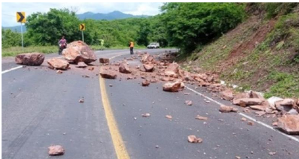
Figura A.4 Rocas caídas en la carretera Colima-Tecomán (SICT, 2022)
