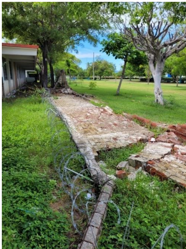
Figura 4.10 Volteo de bardas por falta de contrafuertes y escaso acero de refuerzo
