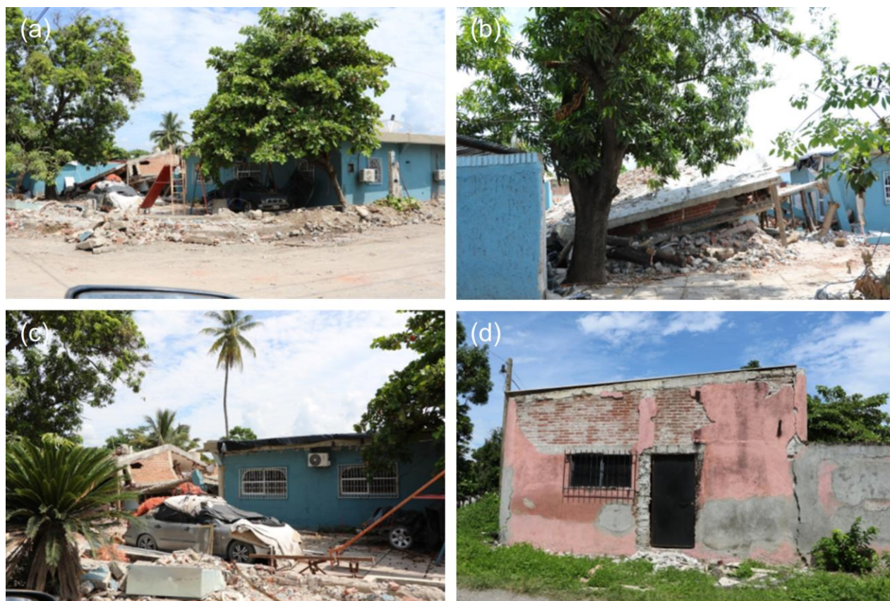
Figura B18. (a, b y c) Viviendas colapsadas y d) vivienda con daños menores
