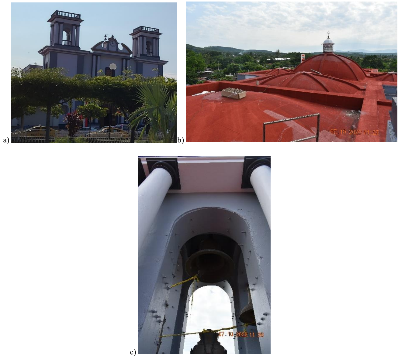
Figura 5.10 Iglesia de Santa María Magdalena, Pueblo Juárez: a) fachada, b) refuerzo de bóvedas, c) refuerzo de campanario
