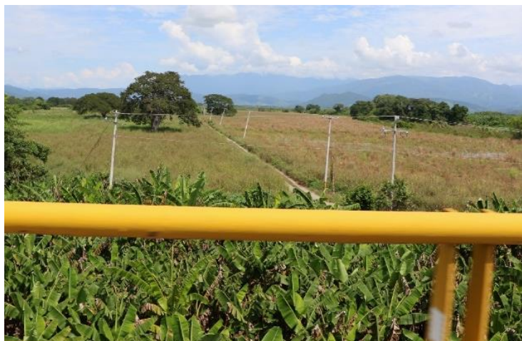
Figura 3.37 Postes de concreto para líneas de transmisión inclinados. Vista desde el puente Coahuayana, en la Carretera Costera del Pacífico
