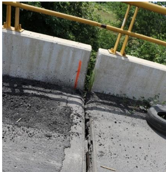
Figura 3.25 Desplazamiento longitudinal del puente
