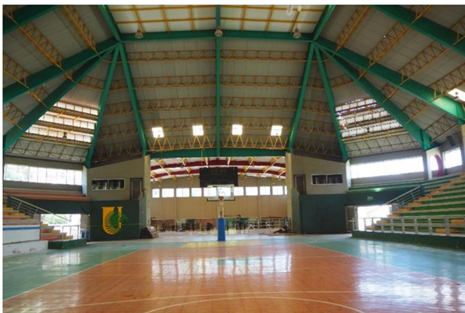
Figura 3.4 Interior del Polideportivo (visto de Este a Oeste)
