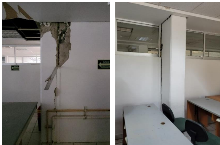
Figura 4.16 Daños en Laboratorio Multidisciplinario: a) muros divisorios con daño por no estar debidamente desligados de los marcos de concreto reforzado, b) caída de plafones por un inadecuado sistema de sujeción (continúa)
