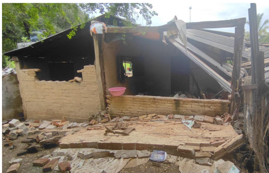
Figura 9.4 Vivienda de autoconstrucción elementos de confinamiento y techo de lámina. Fuente: CENAPRED (2022)
