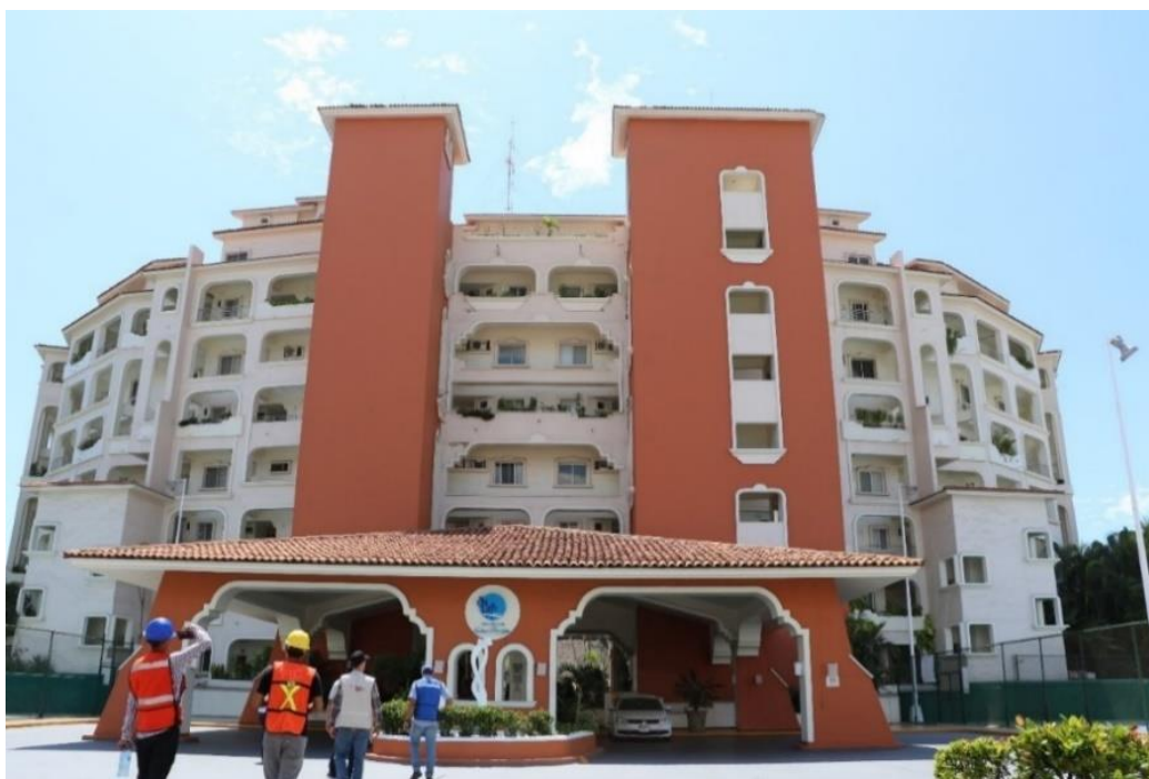
Figura B2. Entrada principal del Condominio Gran Pacífico
