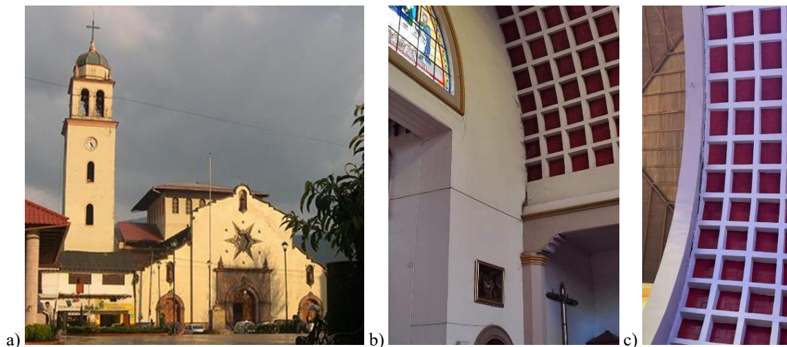
Figura 5.8 Iglesia de Paracho: a) fachada principal, b) daños en muros y c) en la bóveda nervada
