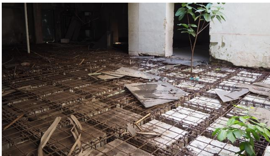
Figura 3.8 Losa con nervaduras en planta baja de museo en el Campus San Pedrito
