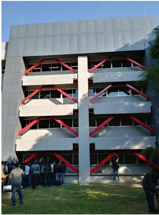
Figura 8.8 Fachada del Edificio G de la UAM, Azcapotzalco
