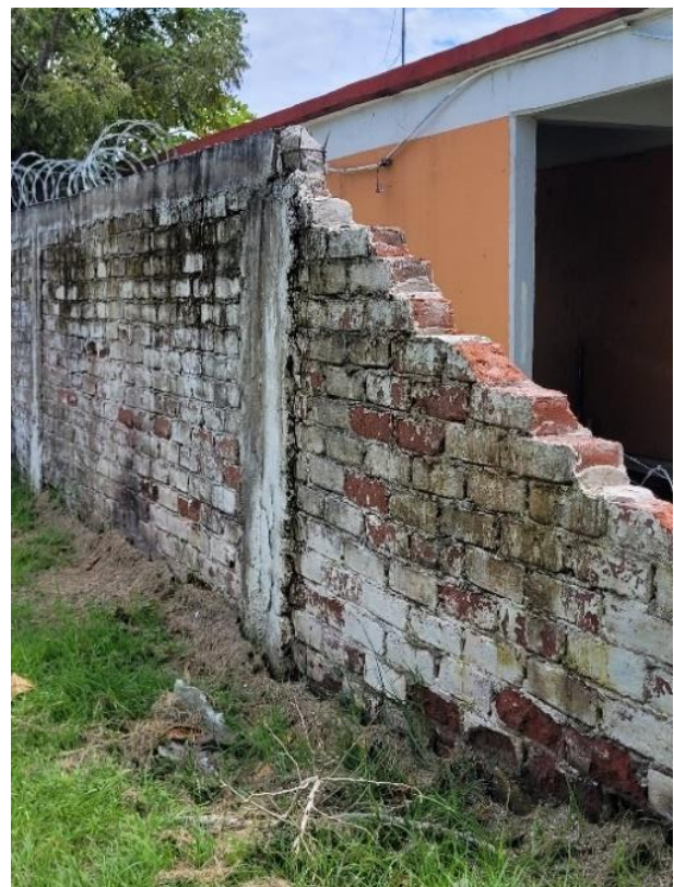
Figura 4.10 Volteo de bardas por falta de contrafuertes y escaso acero de refuerzo
