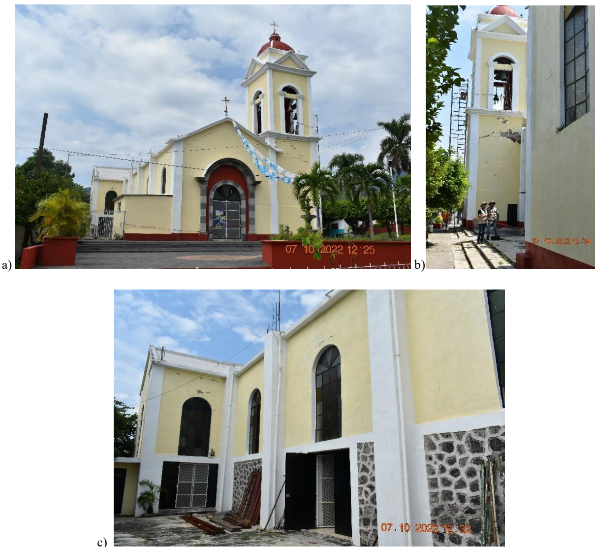
Figura 5.9 Iglesia de Santa María Magdalena, Pueblo Juárez: a) fachada, b) vista posterior de la torre, c) vista lateral
