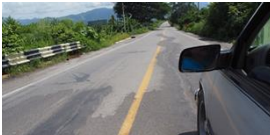
Figura 3.24 Terraplén de acceso al puente Coahuayana, ya reparado
