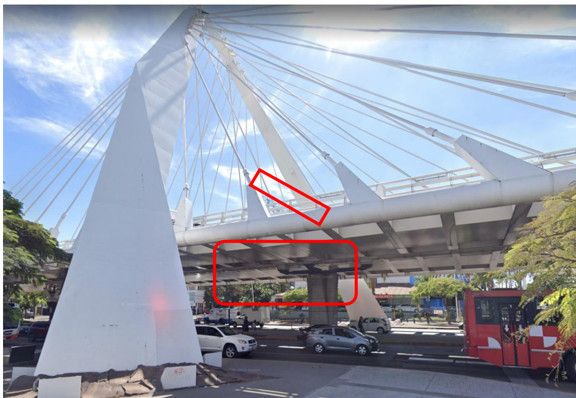
Figura 8.4 Puente Matute Remus, ubicación de aisladores y amortiguadores. Fuente: Google Maps (2023)
